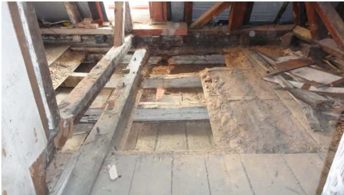
Odkrywka stropu – widok ogólny, widoczne belki 1 i 2, Murłaty M1 i M2, Podciąg 22*27 cm oraz pas dolny więzara dachowego. Po prawej stronie widoczna zachowana polepa gliniana pod deskami podłogowymi.
